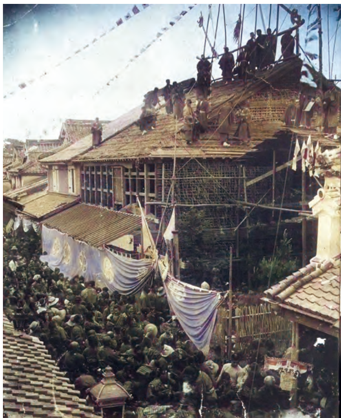
浜ノ町から三軒屋に移転した飯塚屋の棟上げ式。現在の三軒屋児童公園付近。蔵が3つもあり、安売りの時には景品の米俵が入り口に山のように積まれていた
