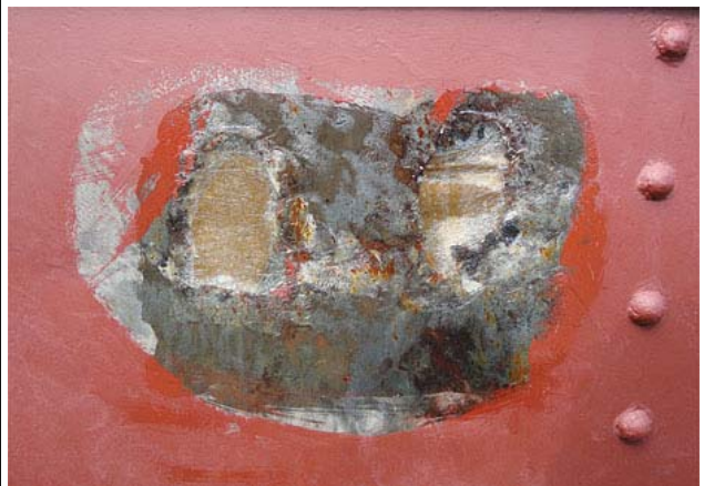
上回りと同様に、旧塗装やサビを落とした後、さび止めに塗装していきます。
