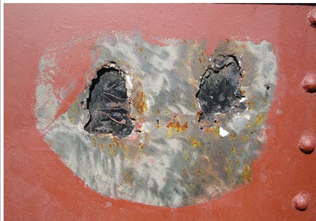
炭水車の外板の修繕の様子です。腐食部分は右の写真のようにFRPとパテを使って丁寧に修繕していきます。
