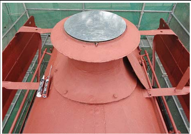
新しく作り直した「ふた」を取り付けた様子です。 これで、地上から見ても煙突に余計な出っ張りが現われなくなりました。
