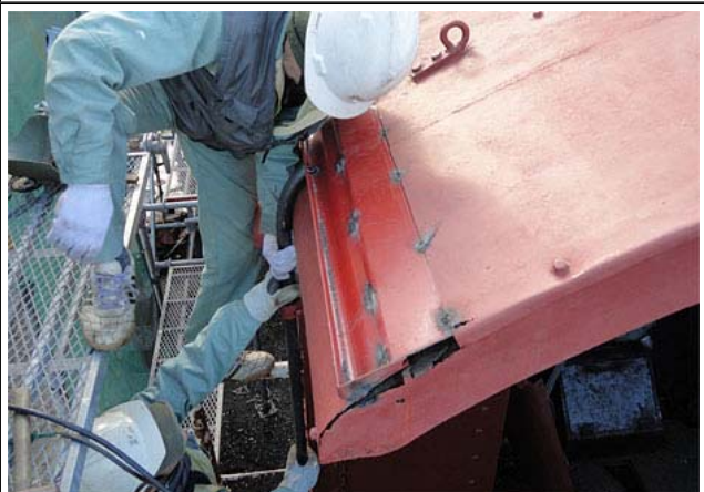
左の写真の雨樋を取り付けた様子です。これで運転室への雨漏りを防げると思います。
