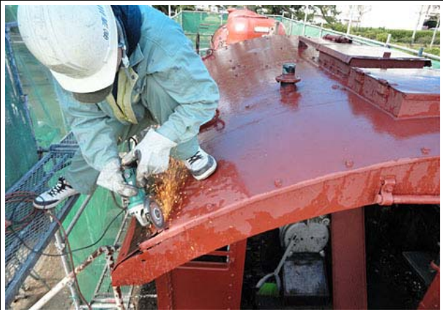
新しく作り直した「ふた」を取り付けた様子です。 これで、地上から見ても煙突に余計な出っ張りが現われなくなりました。
