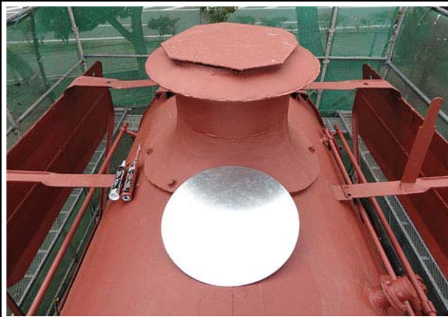
雨水や塵、ゴミ等が煙室に入るのを防ぐための「ふた」(煙突手前の円形のステンレス板)の交換状況です。 保存時に、いびつな形のふたが取り付けられましたので、今回、煙突に合わせた円形で作り直しました。
